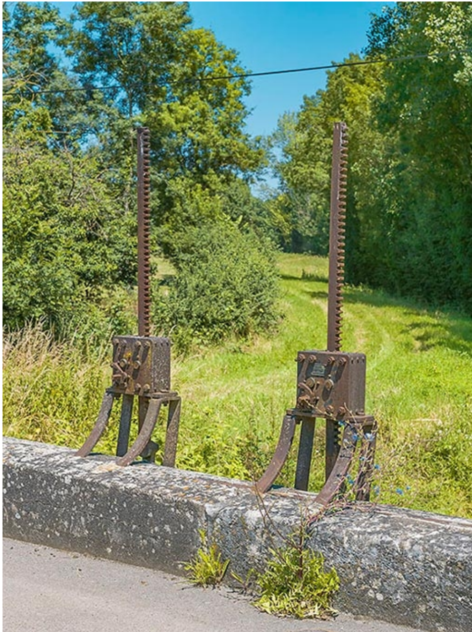
Détail des deux vannes du ponceau.
