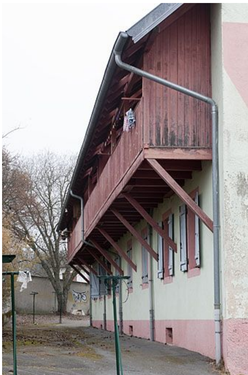
Façade postérieure de l'immeuble de 10 logements.
