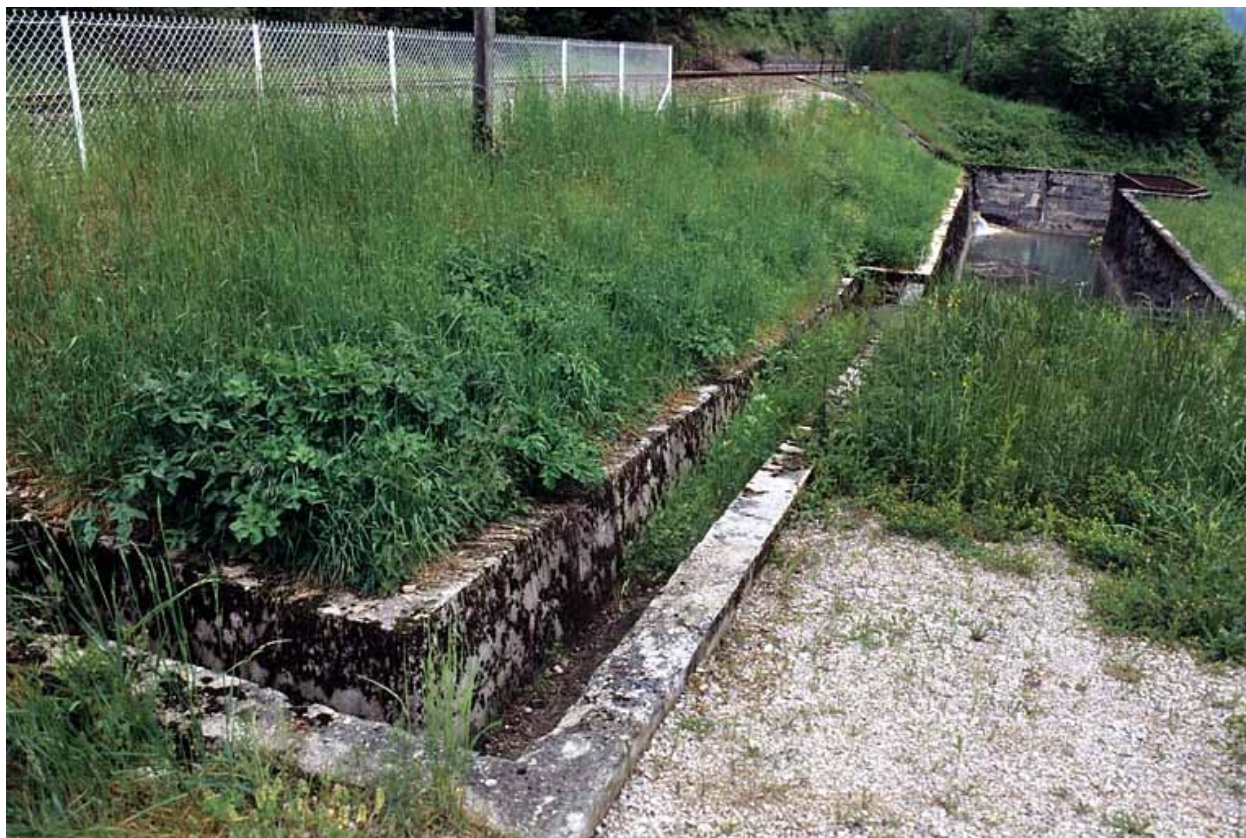
Canal reliant l'aqueduc au réservoir.
