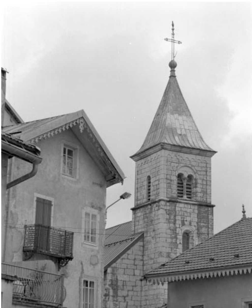
La tour-clocher vue depuis le nord-ouest.
