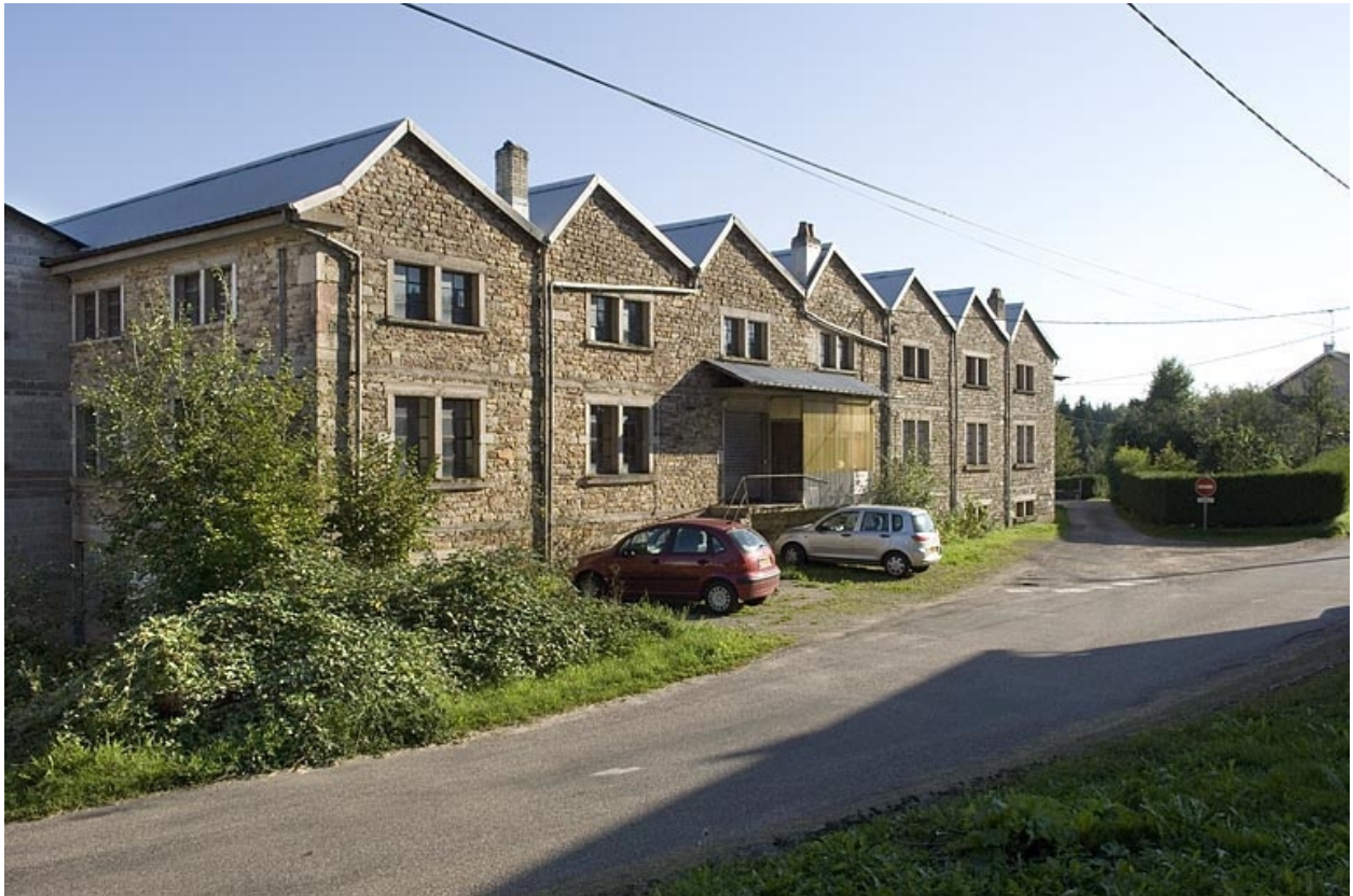
Pignons antérieurs depuis le nord.
