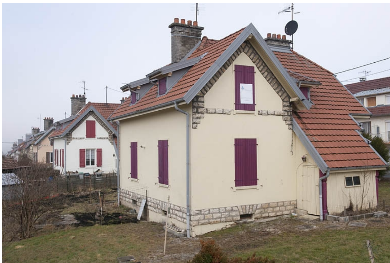
Façades sud des maisons jumelées impasse Bellevue.
