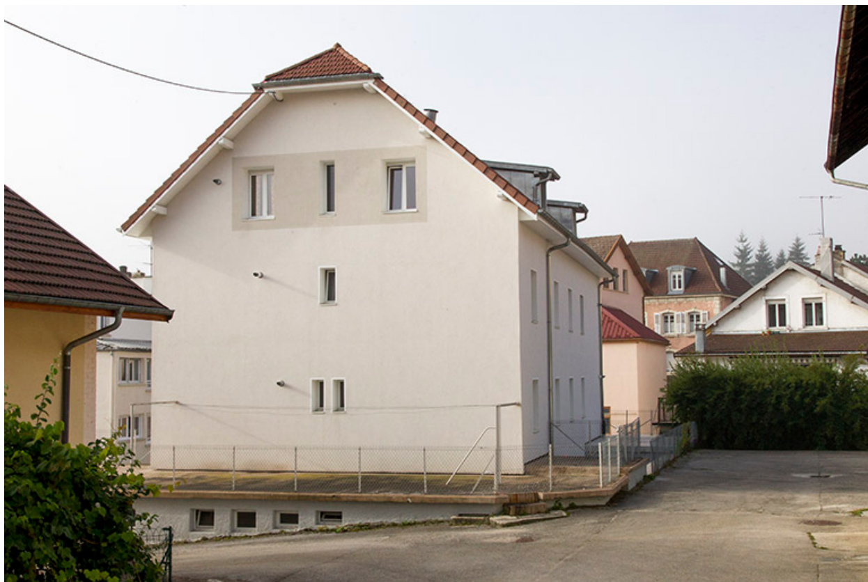
Bâtiment nord : façades latérale droite et postérieure.
