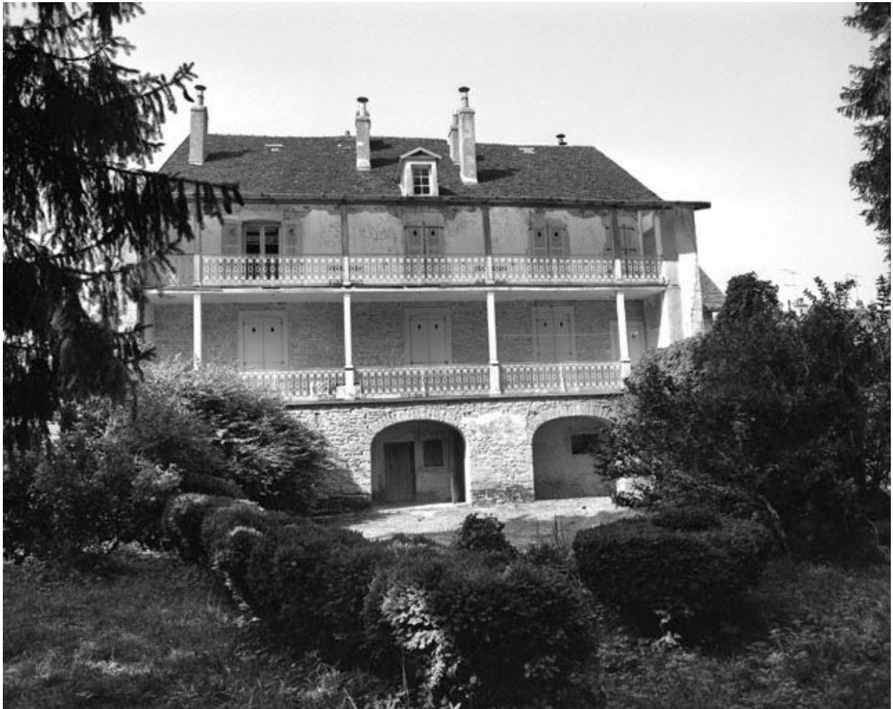
Façade postérieure vue de face.
