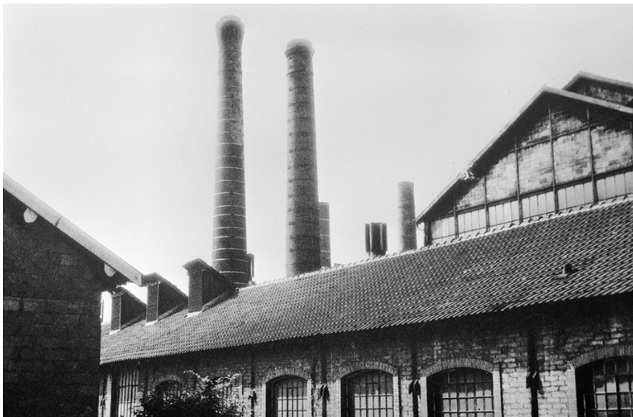
Façade postérieure du bâtiment des compresseurs.
