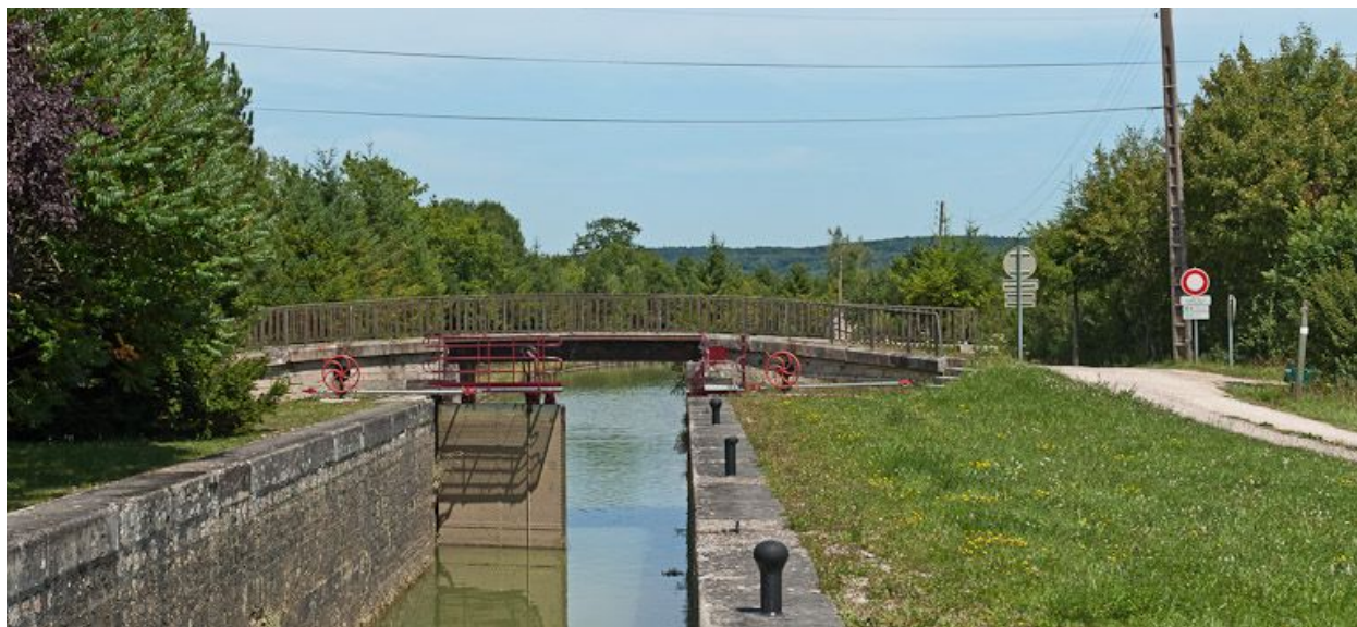
Vue du pont depuis l'amont.
