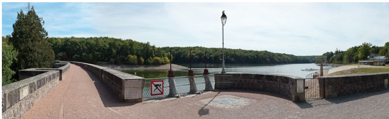
Vue d'ensemble du réservoir.
