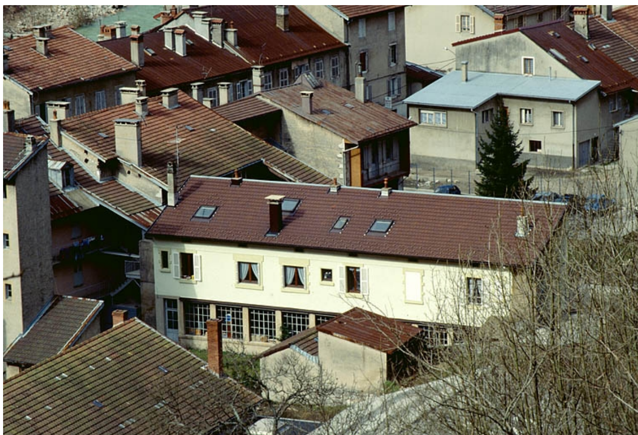
Vue plongeante sur l'atelier de fabrication.
