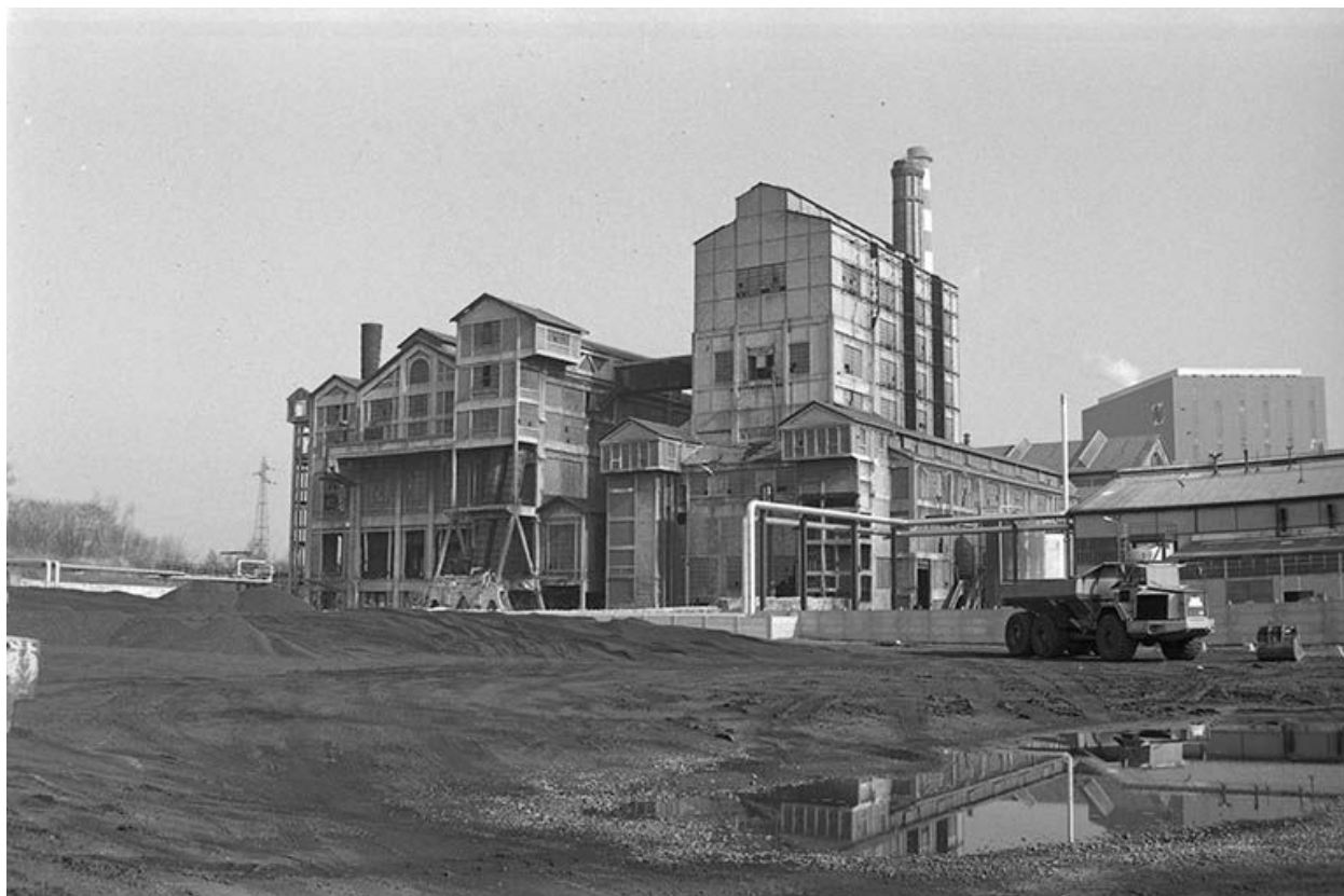
Les chaufferies, pignons sud.
