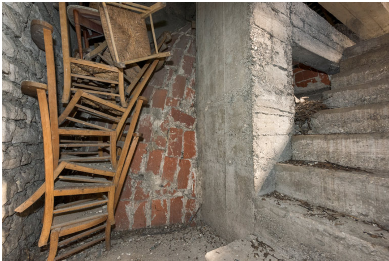
Voûte et escalier du clocher.
