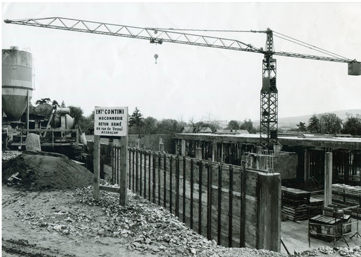
Chantier de construction de l'usine B, fotogr., 1961.
