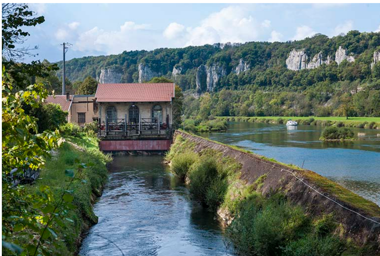
Vue depuis le canal d'amenée.
