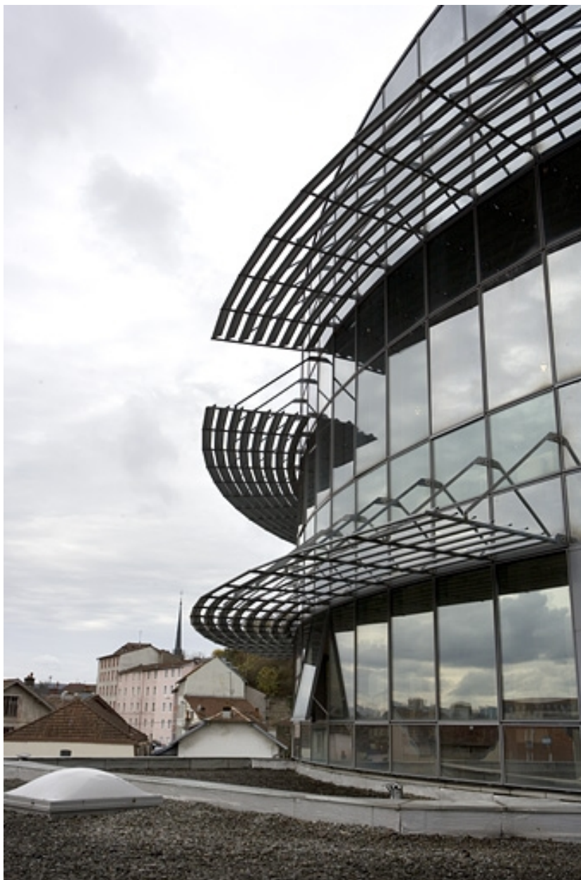
Tour bâtiment D. Détail brise-soleil métalliques.
