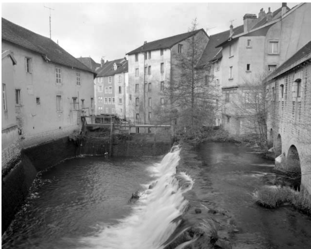
Remplissage du bassin de retenue.
