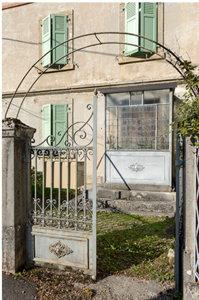
Logement Hugoniot : véranda est, depuis l'entrée.
