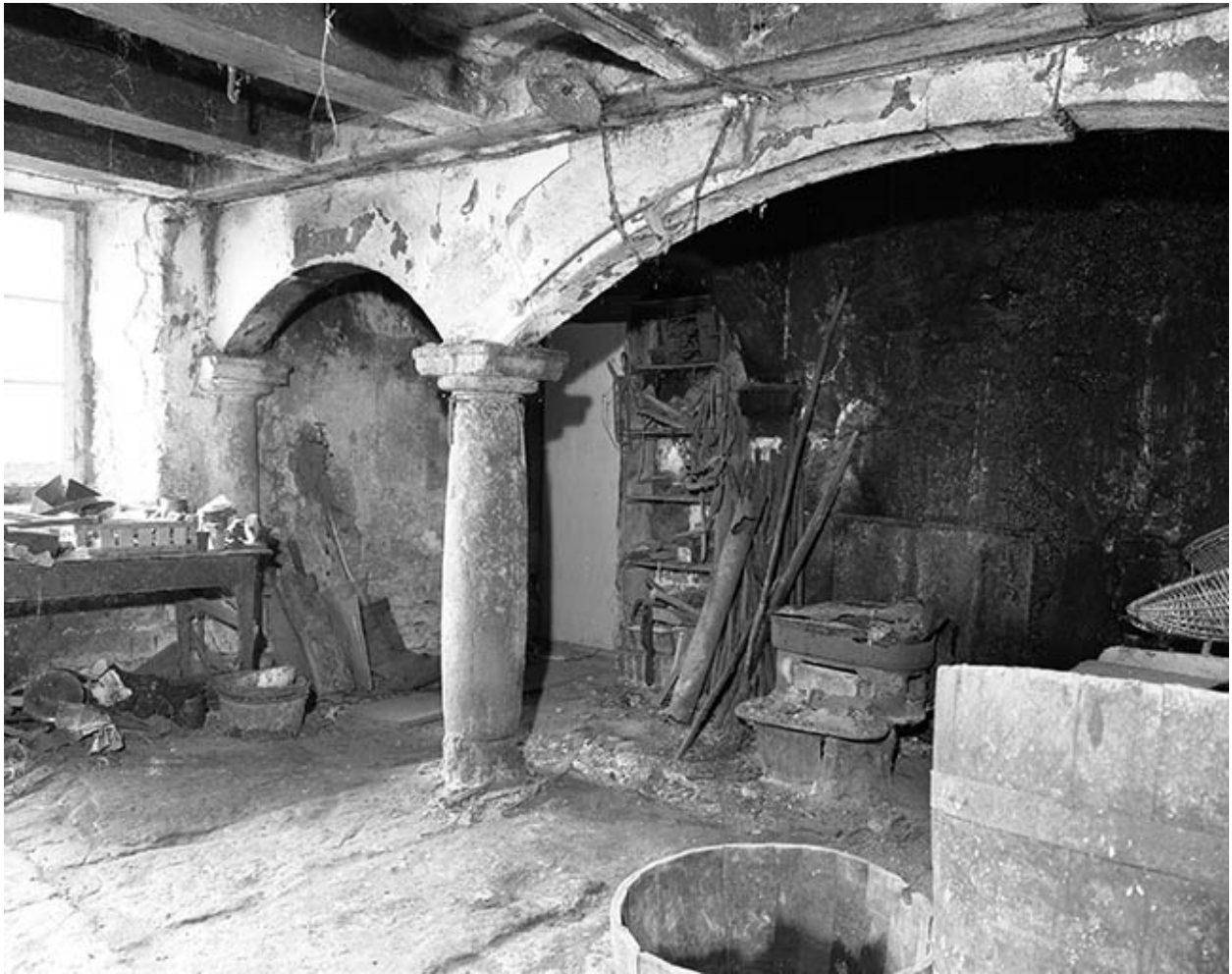
Cheminée de la deuxième cuisine.
