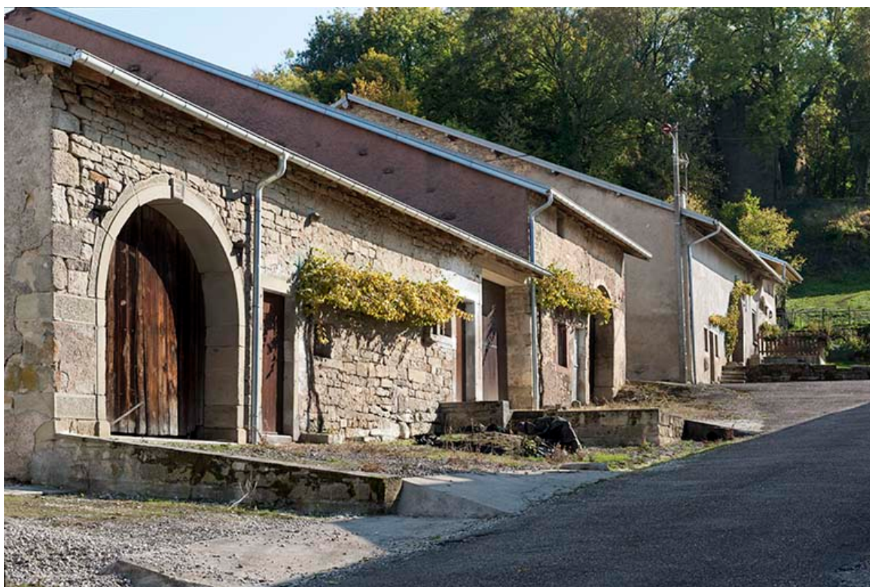
Alignement rue de la fontaine.
