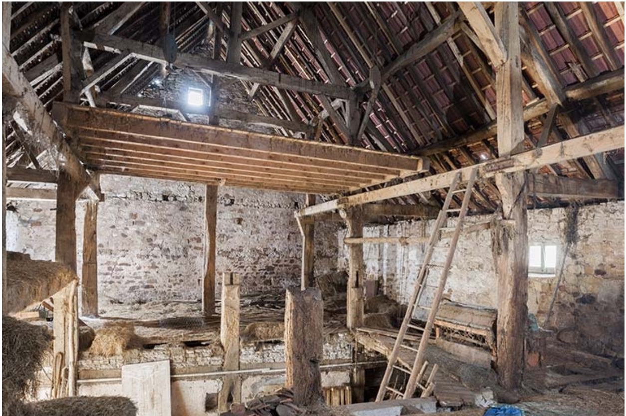
Intérieur de la grange.
