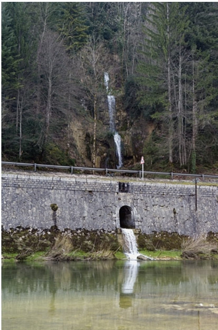
Aqueduc du ruisseau du Tournachut.
