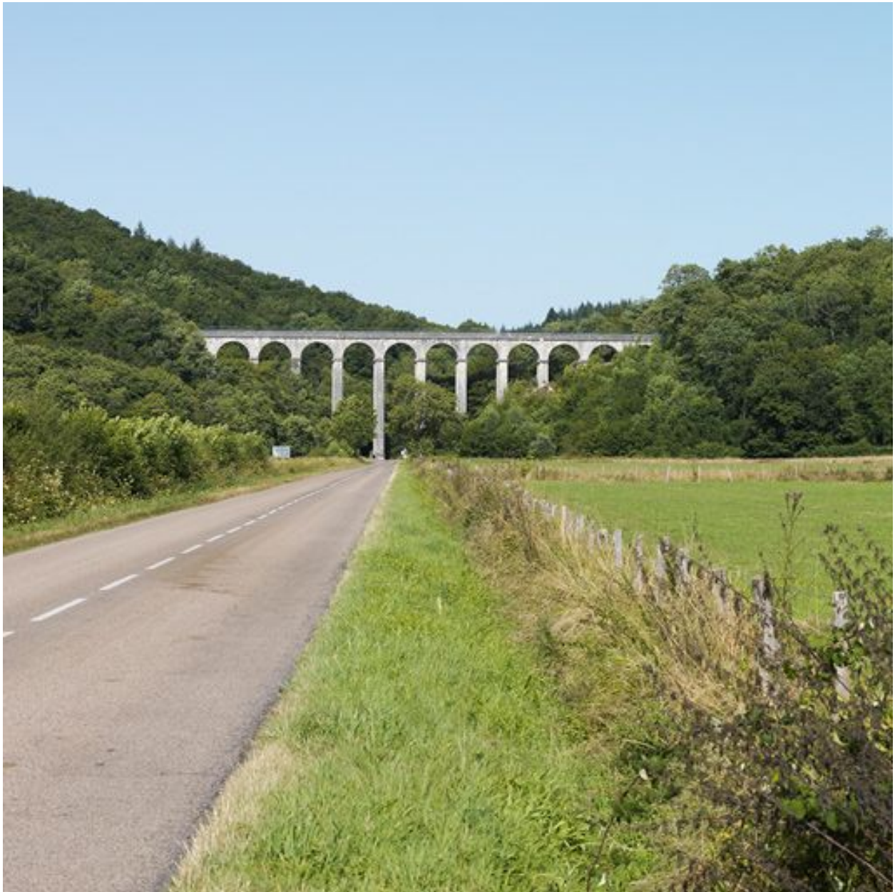
L'aqueduc de Montreuillon, depuis la vallée.
