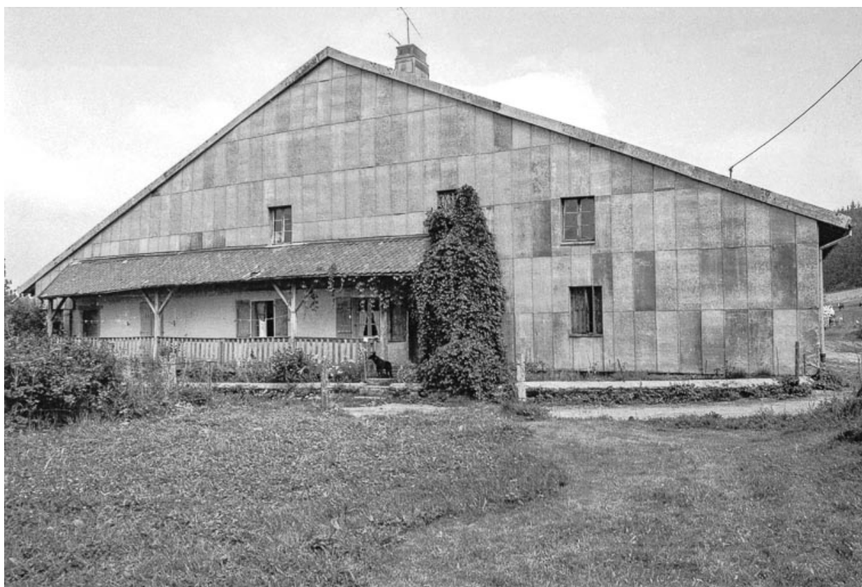
Façade antérieure vue de face.
