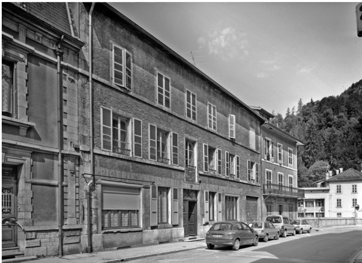
Elévation antérieure, de trois quarts gauche.
