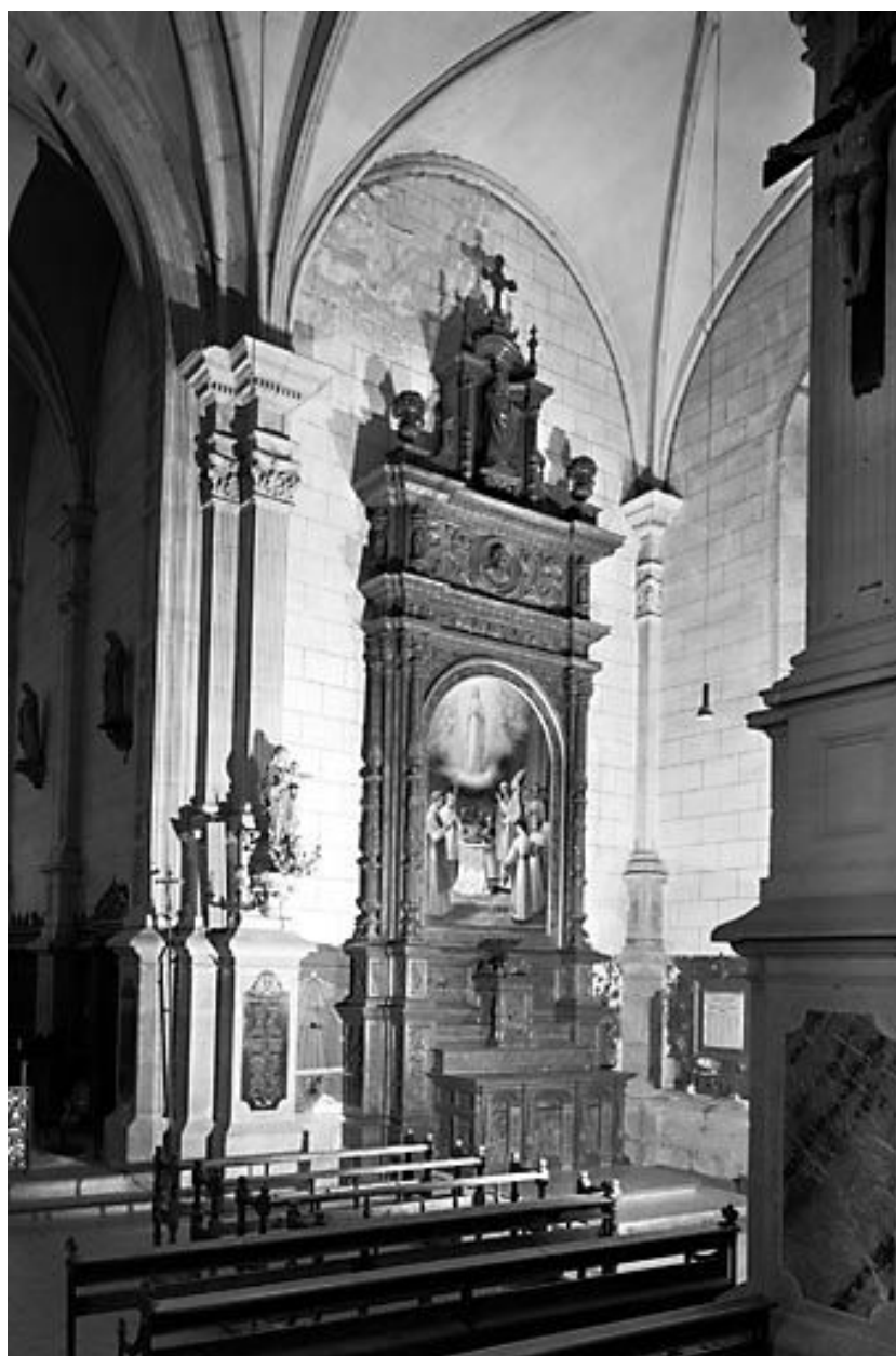
Autel-retable sud : vue d'ensemble.
