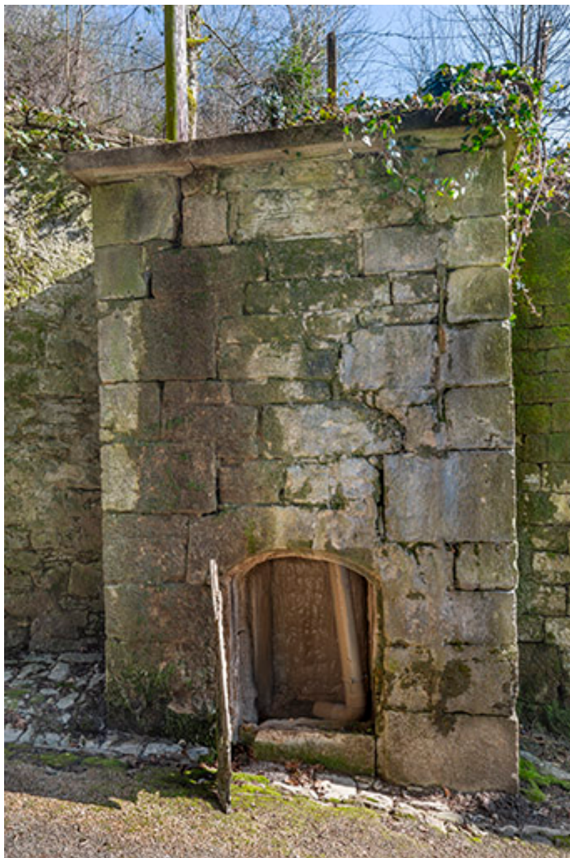
Escalier de Saint-Anatoile. Vue rapprochée du captage.
