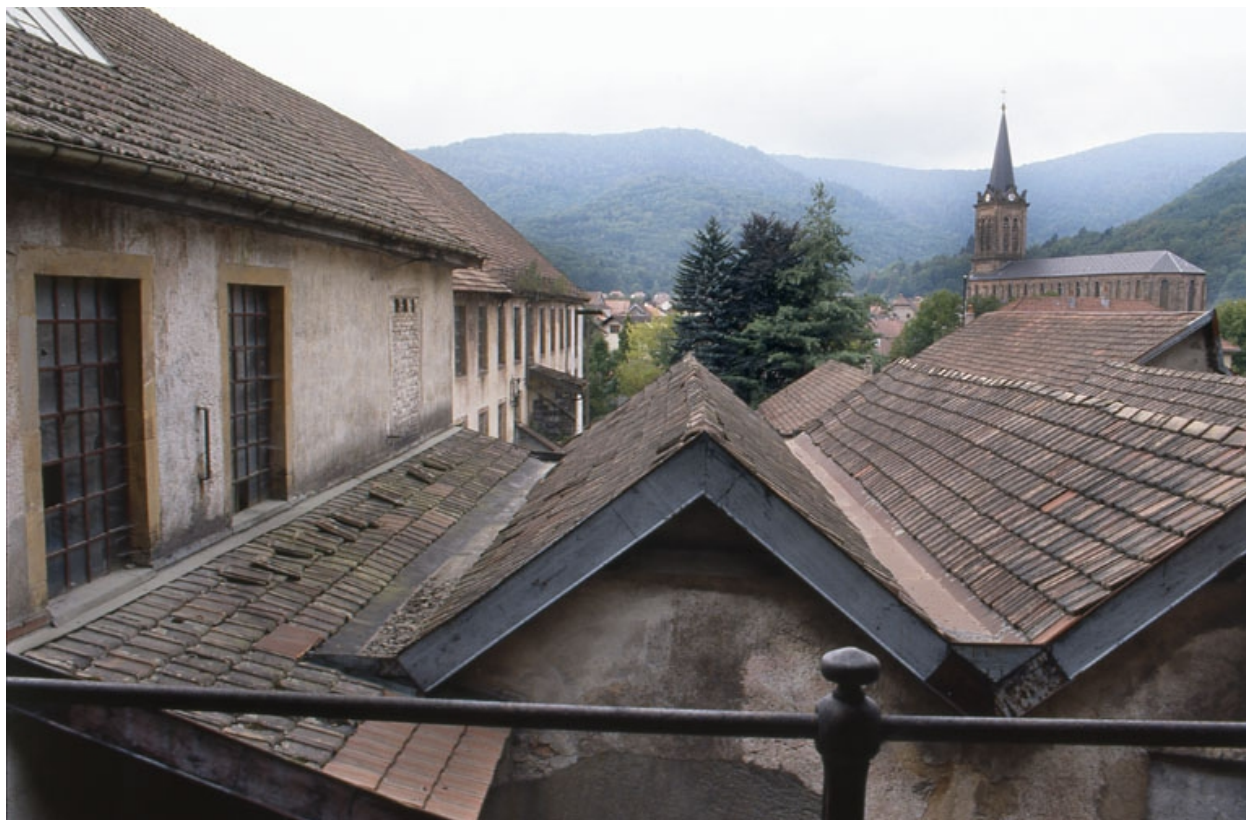
Toitures depuis l'est.
