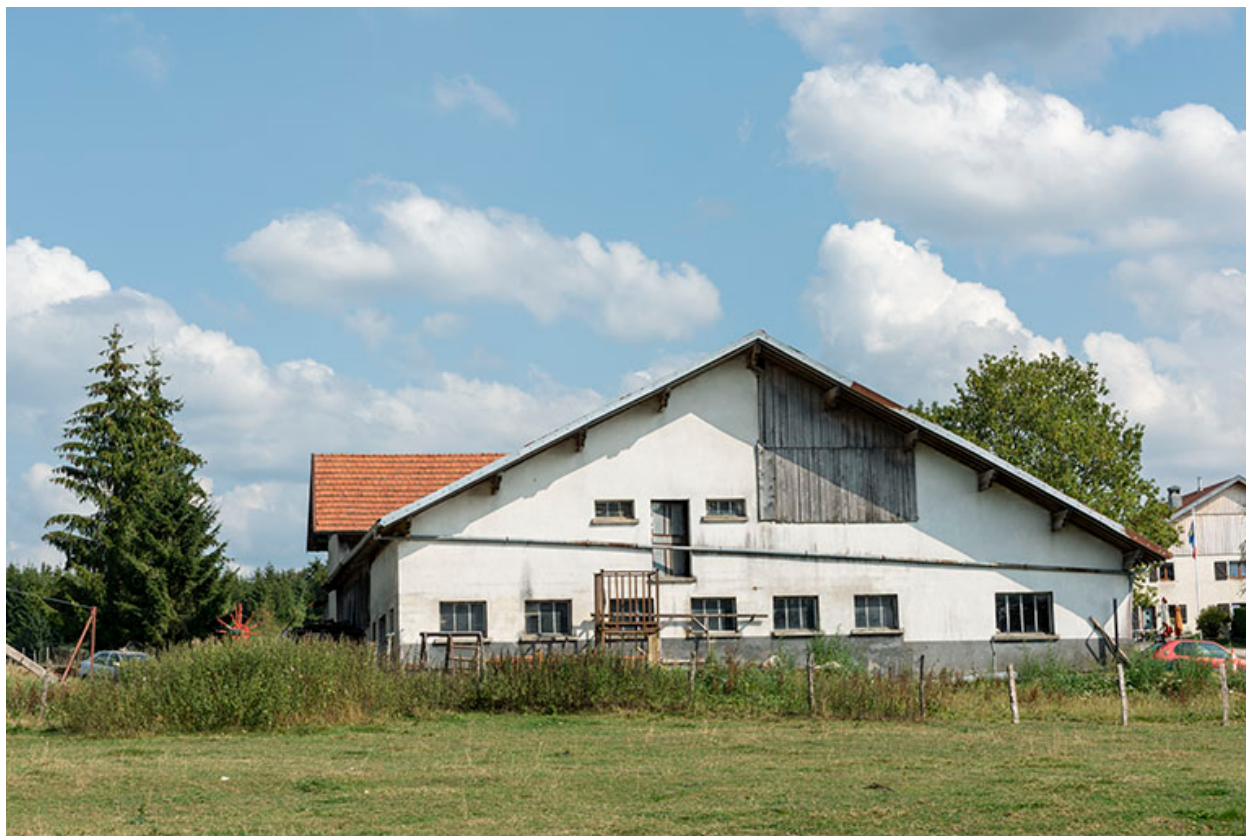
Façade latérale gauche.
