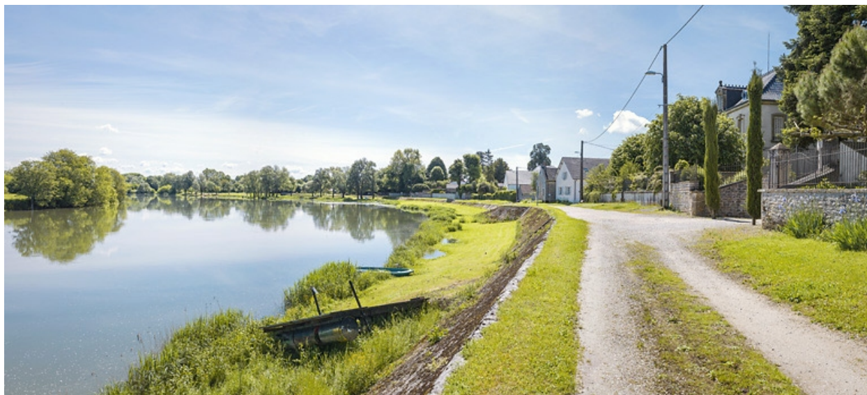
Vue d'ensemble de la digue, prise d'aval.
