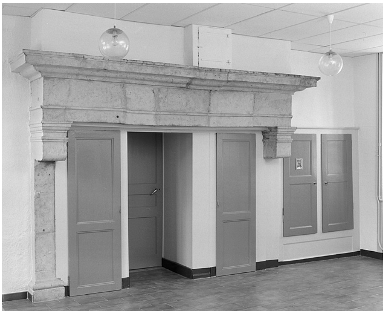
Cheminée dans l'ancienne cuisine au rez-de-chaussée.
