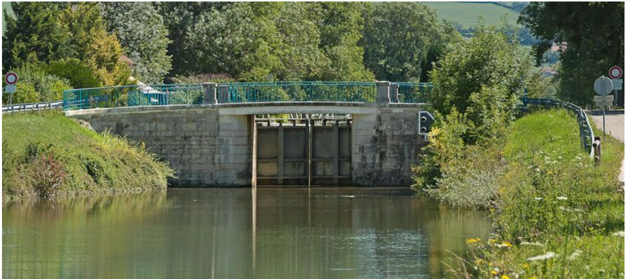
Vue du pont depuis l'aval.
