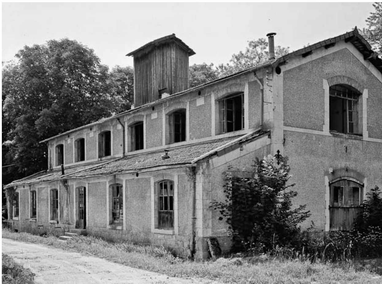
État en 1984, vue depuis le sud-est.
