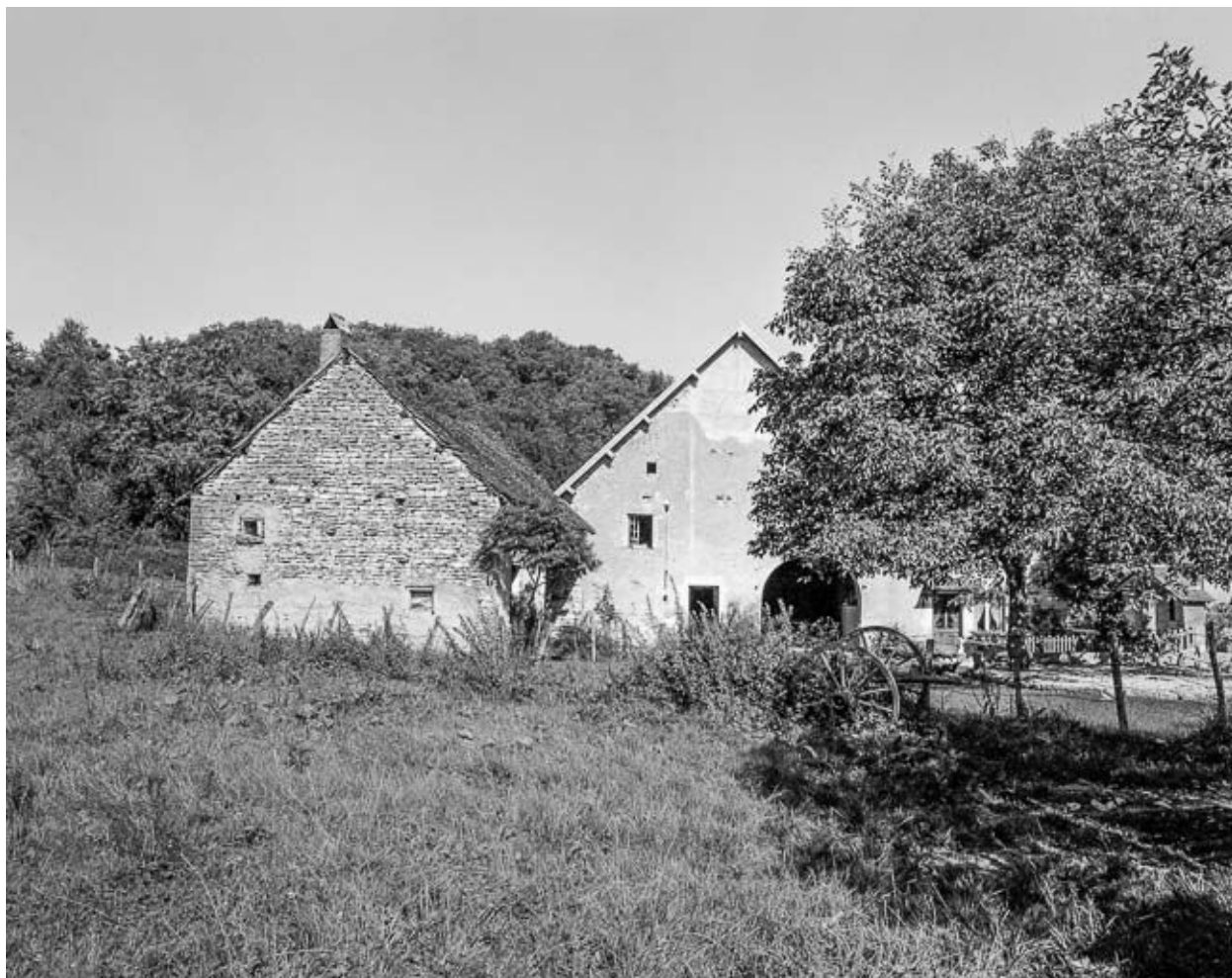
Façade sur cour et dépendances.
