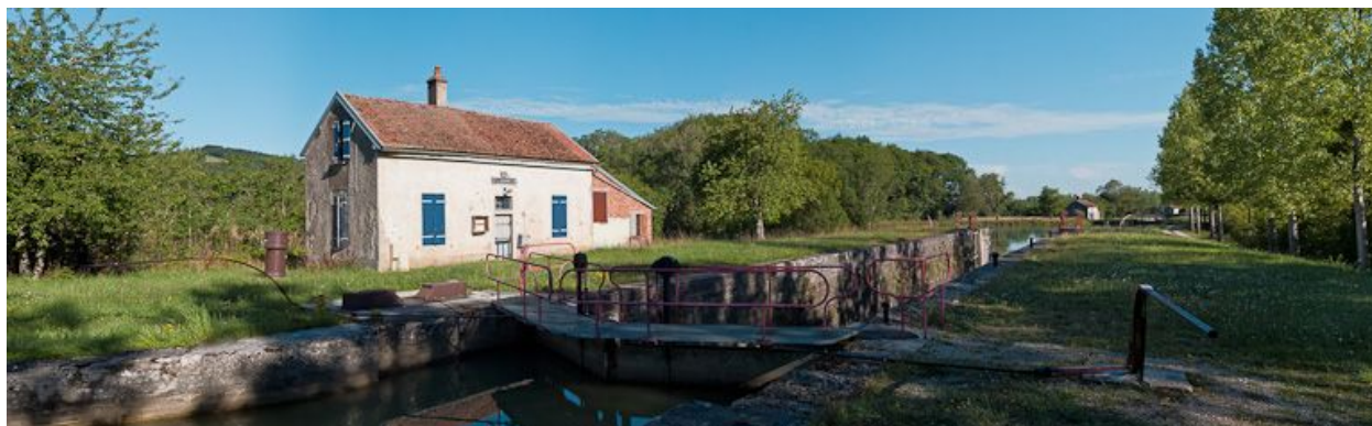
Vue d'ensemble du site d'écluse.
