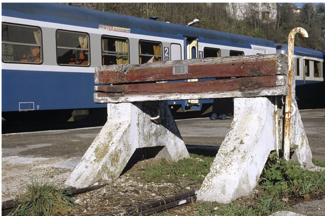
Butoir de la voie 5.
