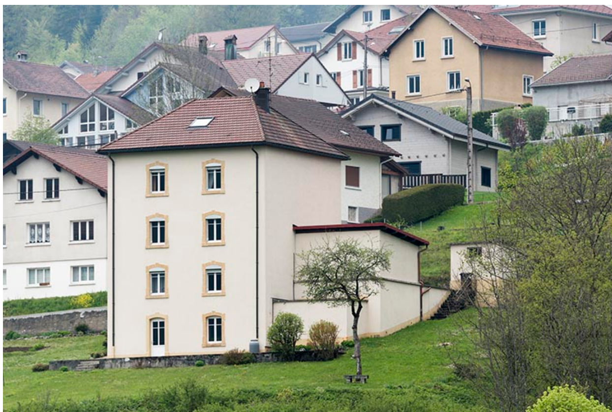
Façades postérieure et latérale gauche.
