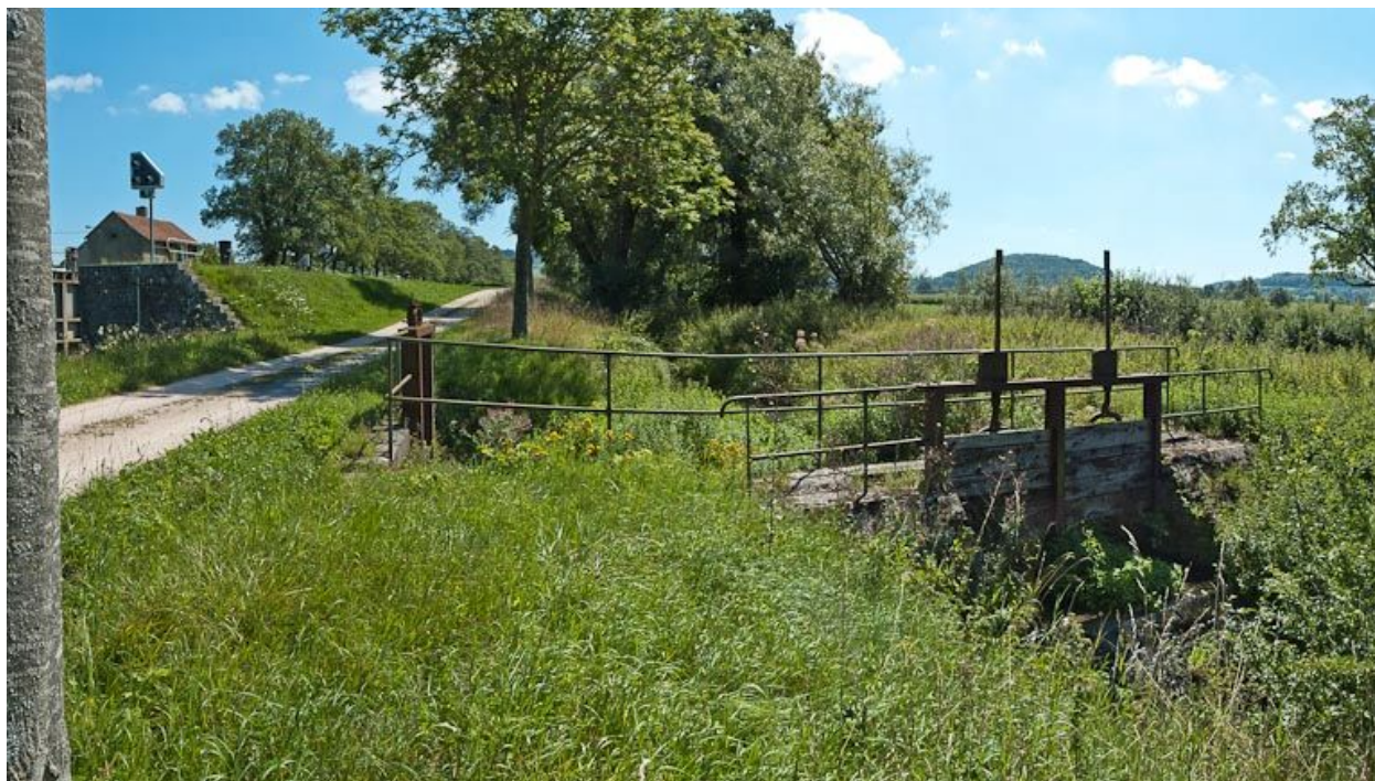
Vue des vannes de prise d'eau.
