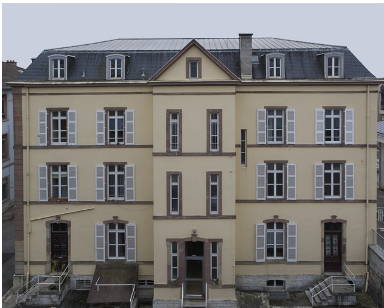
Vue façade postérieure bâtiment A.
