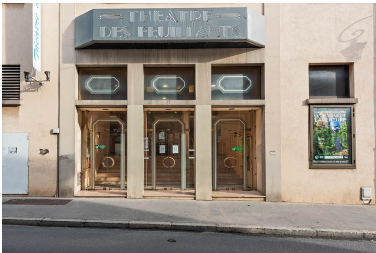
Façade antérieure : entrée.
