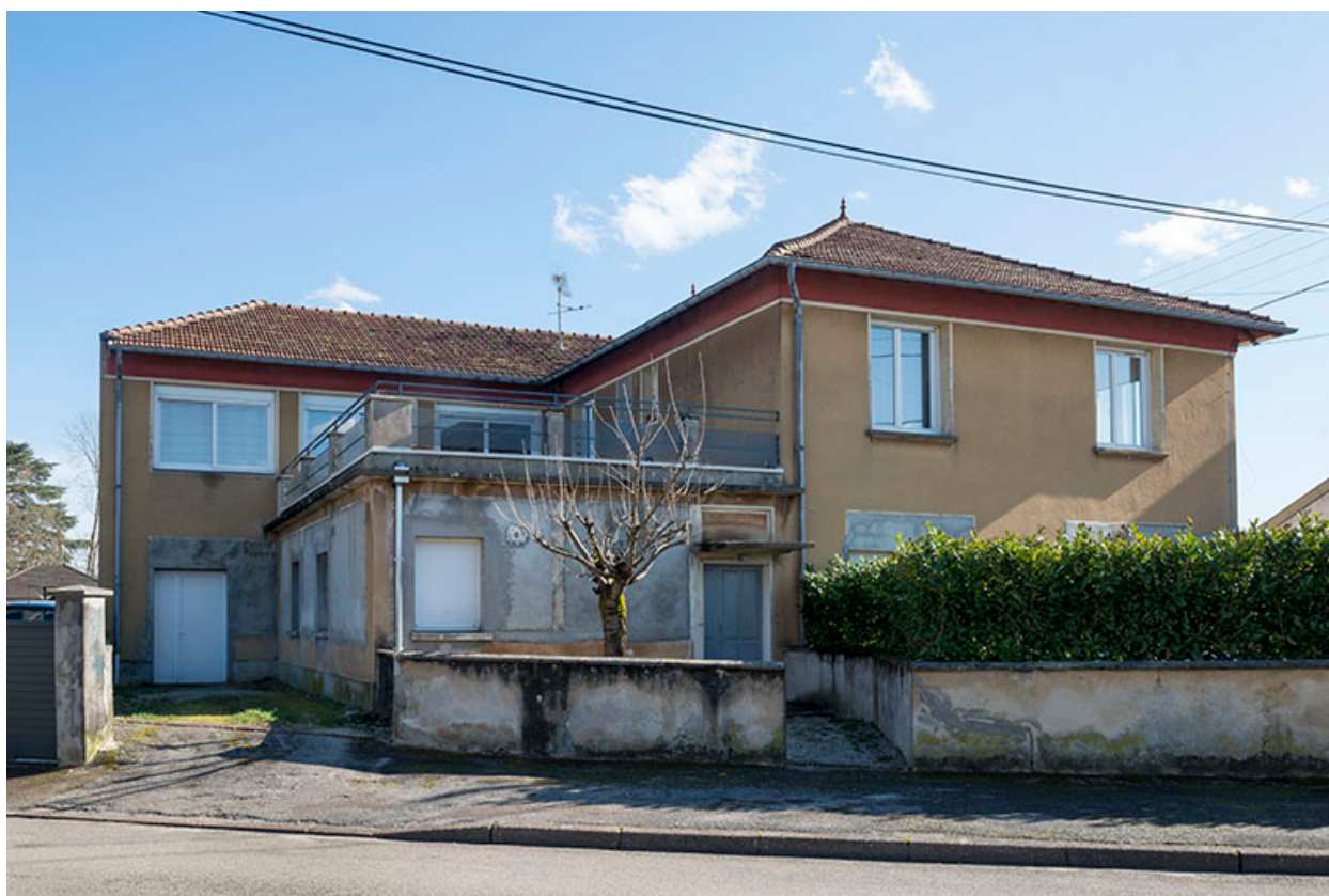
Vue depuis le nord.
