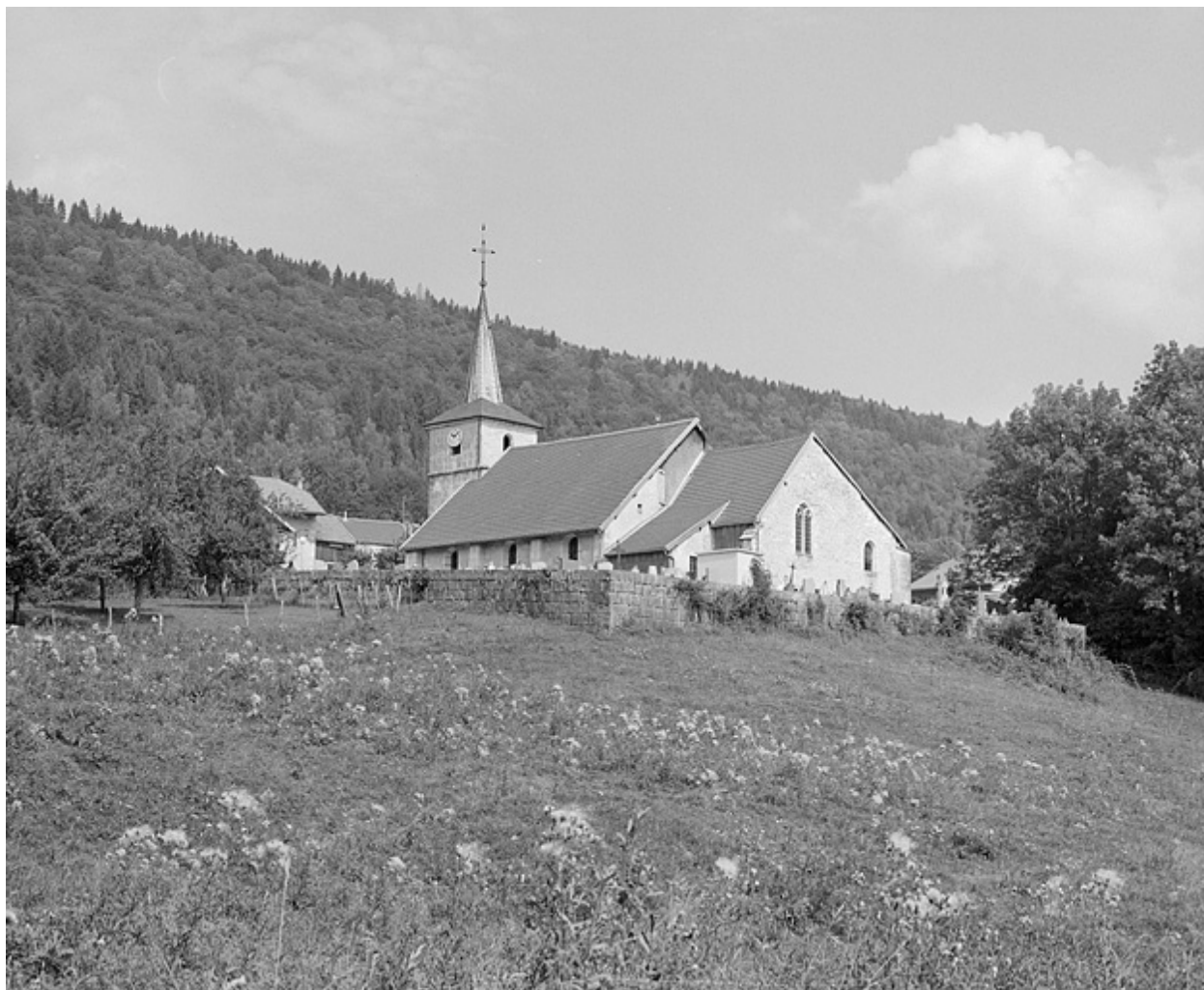
Vue de situation depuis le sud-est.
