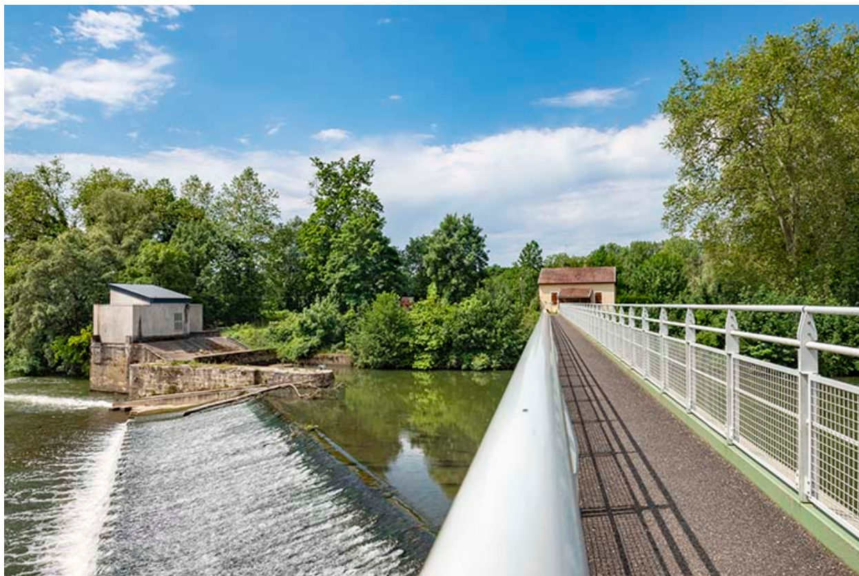
Barrage d'Apremont, vue depuis la passerelle.
