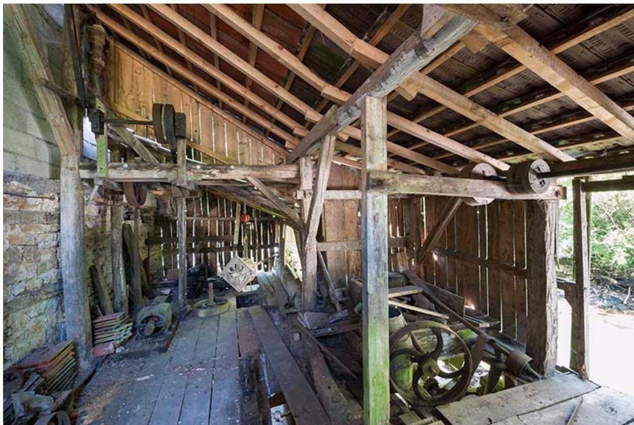
Vue intérieure du bâtiment d'eau.
