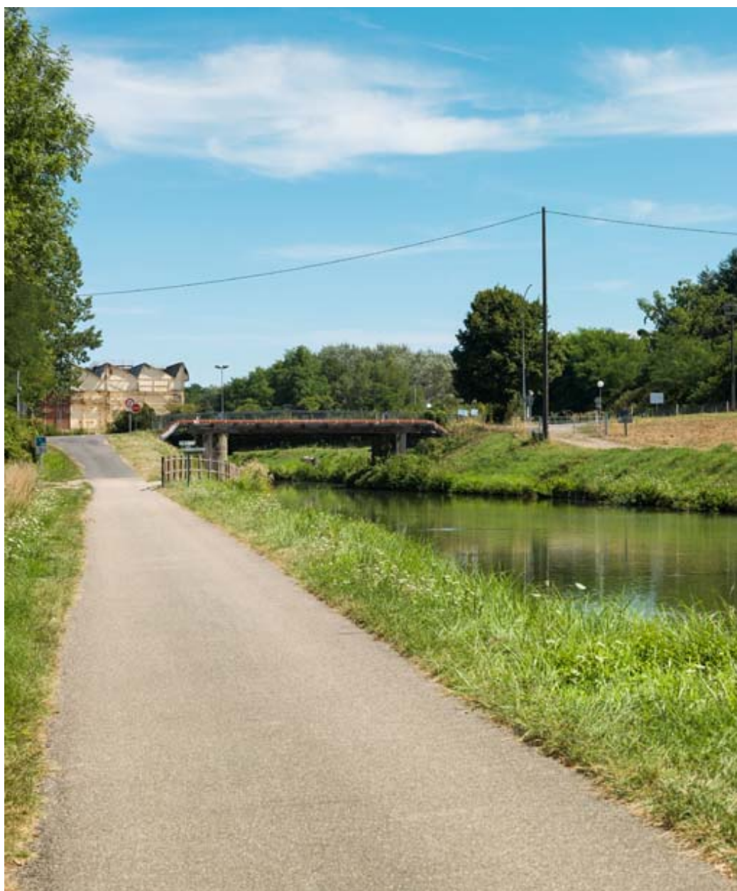
Vue d'ensemble du pont.
