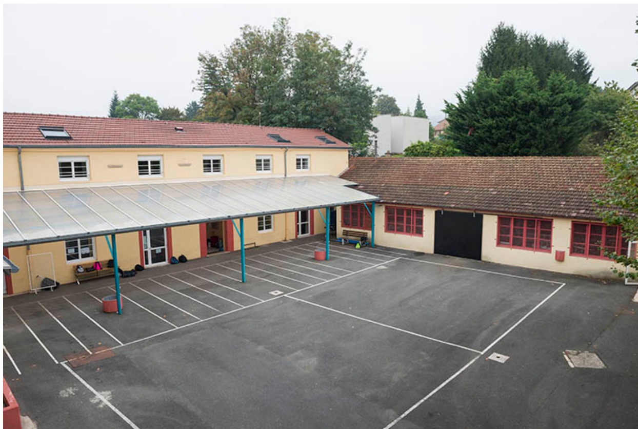
Externat - cafétéria : vue des façades sur cour.
