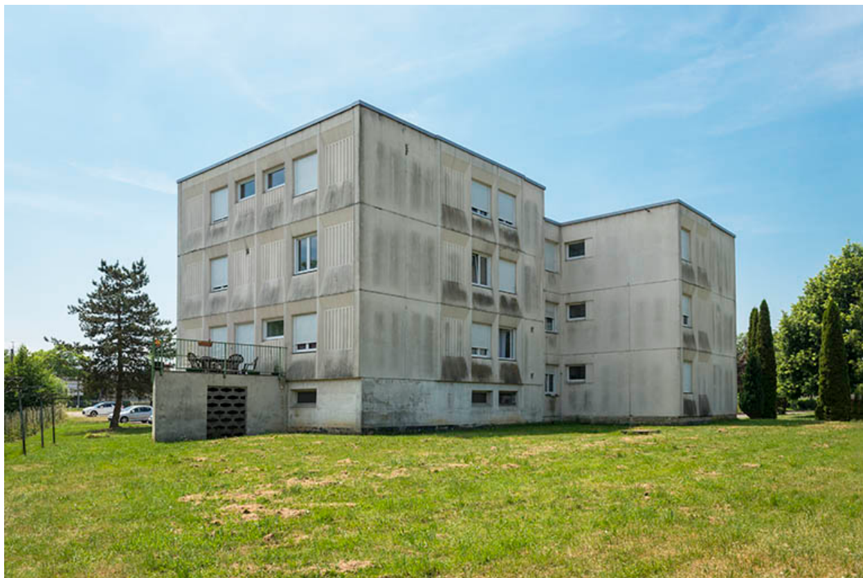
Angle nord-est des logements de fonction.
