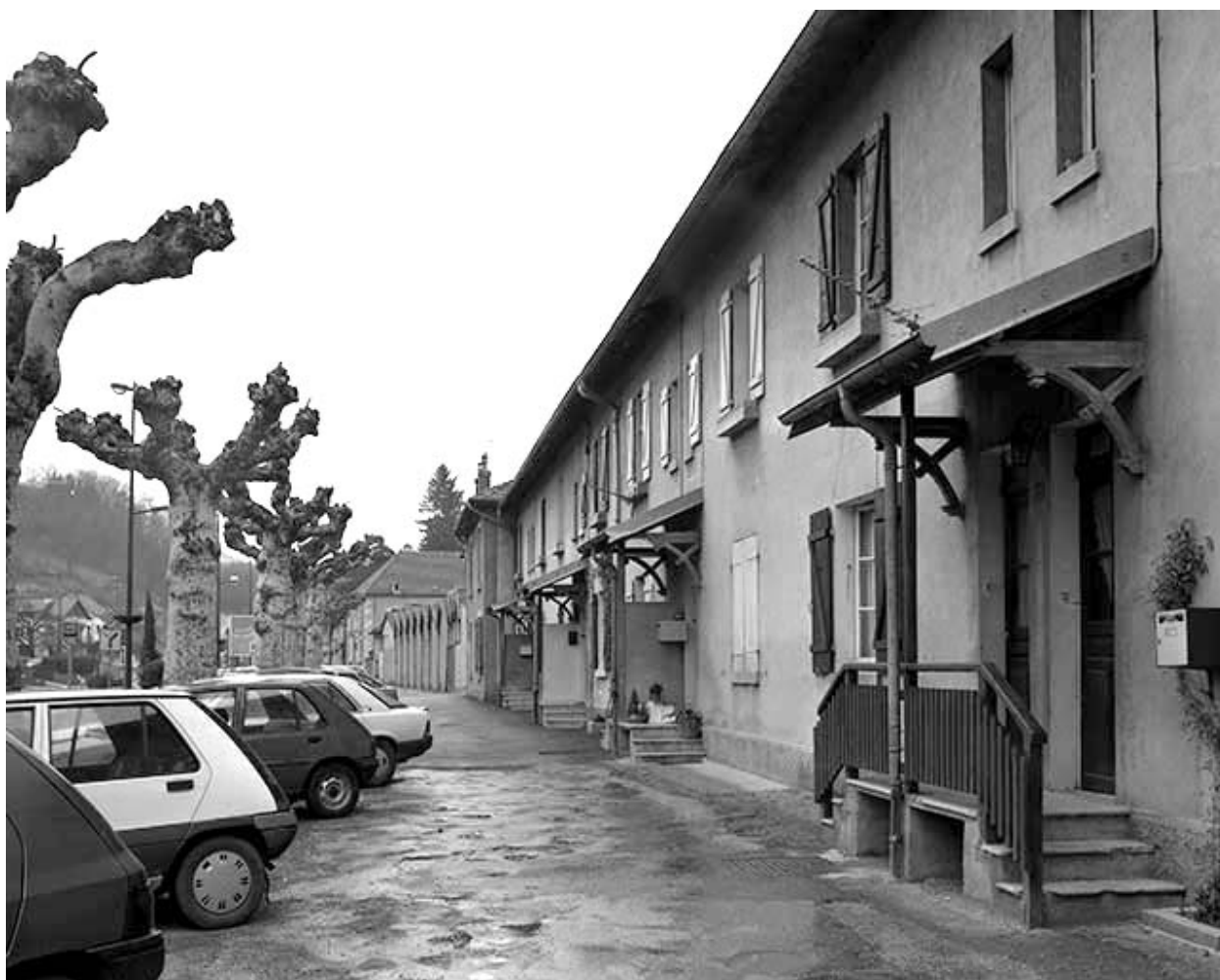
Façade antérieure des logements ouvriers.
