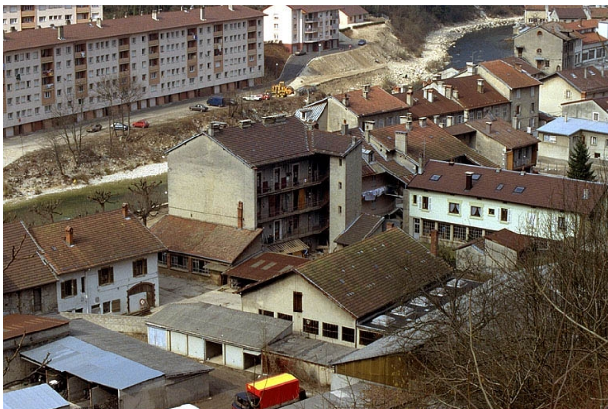
Vue d'ensemble plongeante depuis le sud-est.
